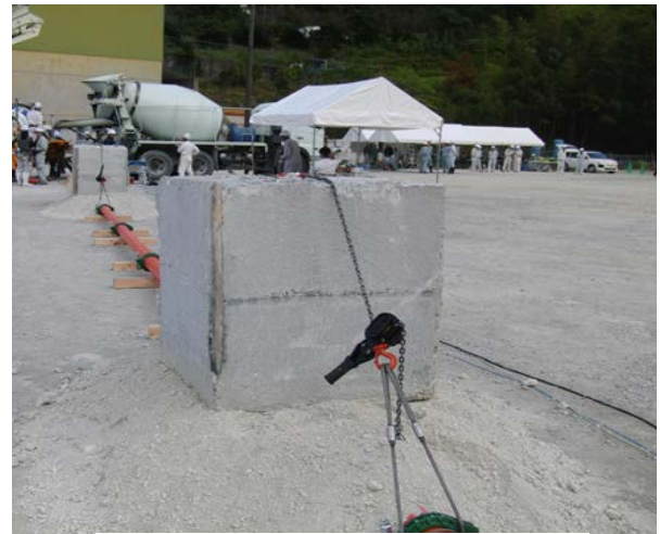
写真 1 配管の固定状況(コンクリート塊)
