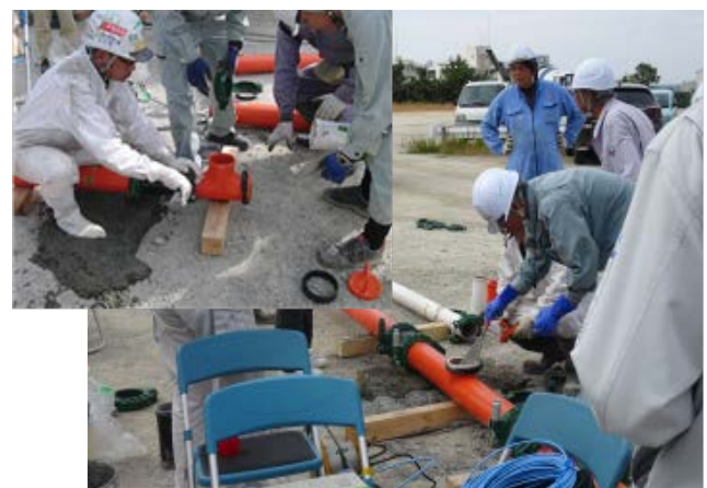
写真 3 圧送用先行材投入状況
