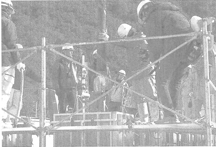
フィールド実験の様子
